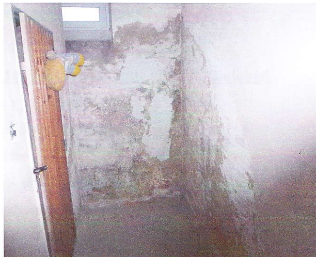
14 – Obvodová stěna je provlhlá nejvíce v úrovni chodníku.
