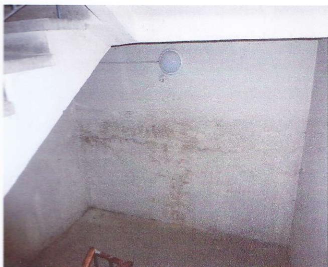
15 – Obvodová stěna je provlhlá nejvíce v úrovni chodníku.
