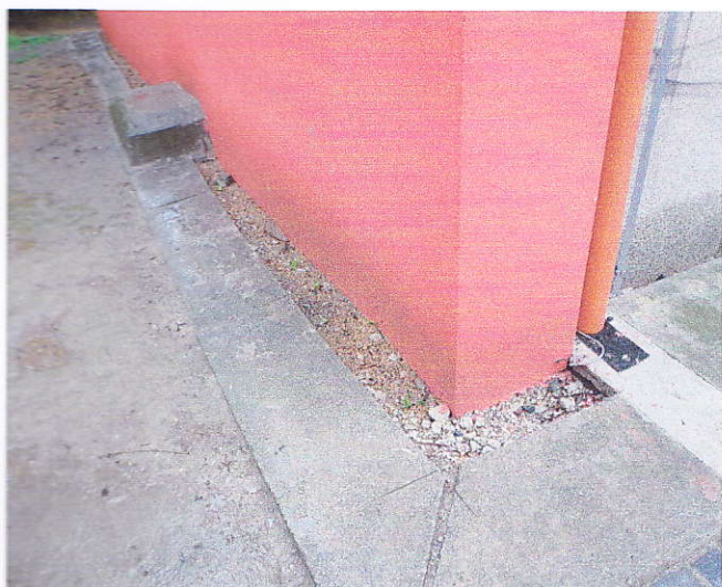
9 – Kolem štítuje okap.chodníček propustný.
