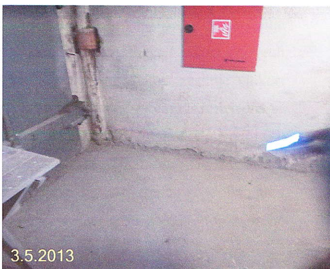
18 – Vlhko ve 2.suterénu kolem dešťového svodu.
