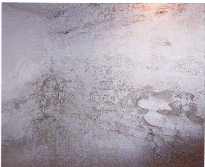
11 – Obvodová stěna s okap.chodníčkem je provlhlá.
