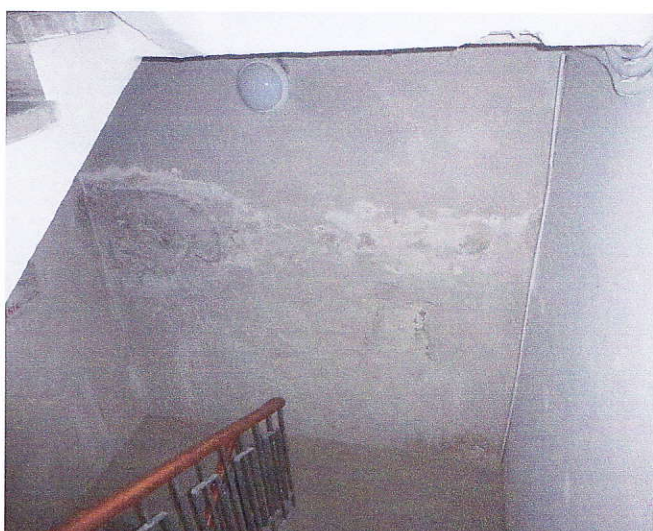
12 – Obvodová stěna s okap.chodníčkem je provlhlá (v úrovni chodníku).
