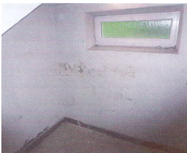
16 – Obvodová stěna je provlhlá nejvíce v úrovni chodníku.
