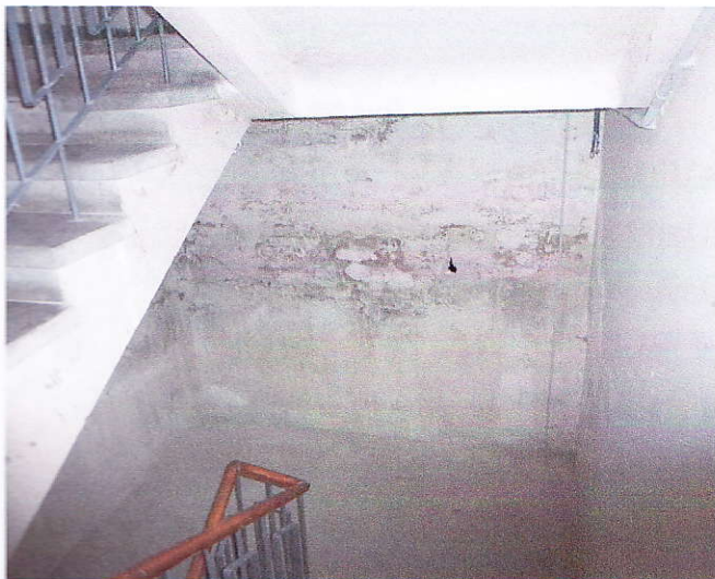
13 – Obvodová stěna je provlhlá nejvíce v úrovni chodníku.
